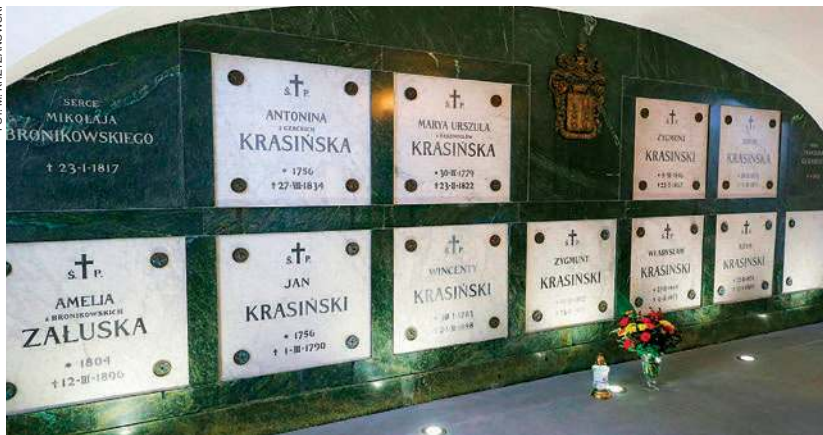
Podziemia w kryptach Krasińskich – stan obecny
