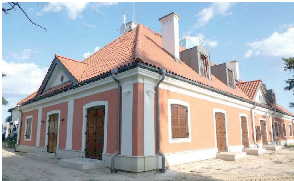
Odremonowany ratusz już błyszczący w centrum Końskowoli. Na jego wyposażenie będzie trzeba przeznaczyć jednak większą pulę pieniędzy
