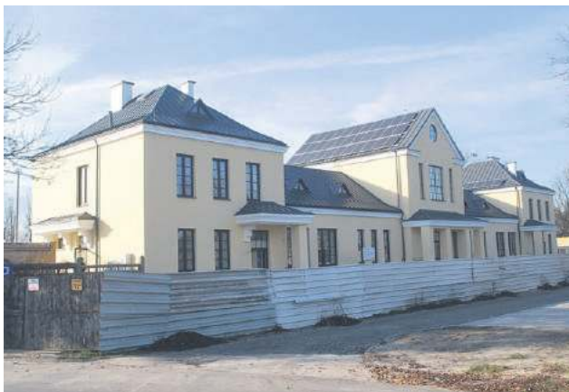
Centrum Integracji Społecznej w budynku dworca PKP
