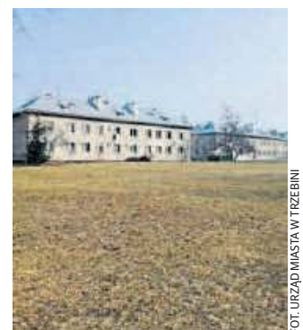
W tym miejscu na osiedlu Gaj powstanie nowy blok socjalny
