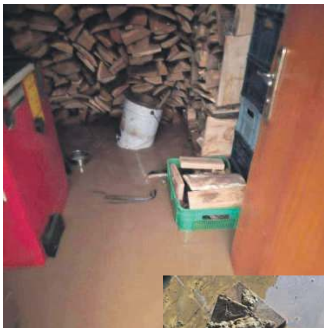
Zalało wiele pomieszczeń
