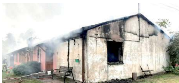
Strażacy zdjęli z dachu kilka arkuszy blachy. Poprzez powstałe otwory gaszono palącą się konstrukcję domu i oddymiano wnętrze
