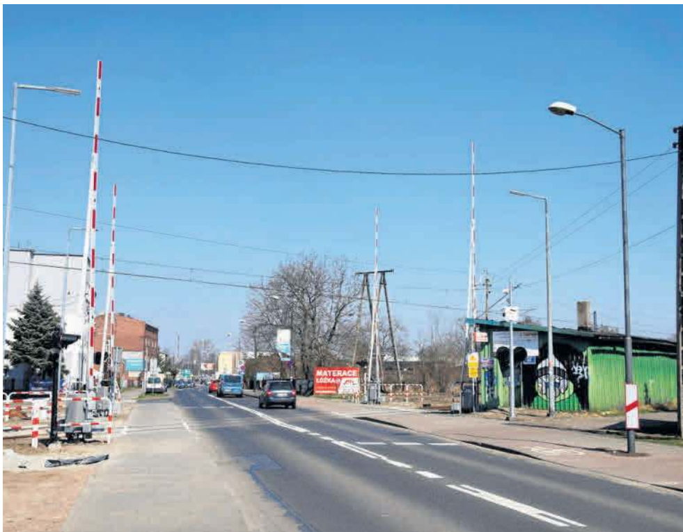
Na przejeździe kolejowym na ul. Jankego, przy dawnej stacji Katowice Ochojec, trzeba zachować ostrożność. Po kilku latach przerwy znowu jeżdżą tędy pociągi
