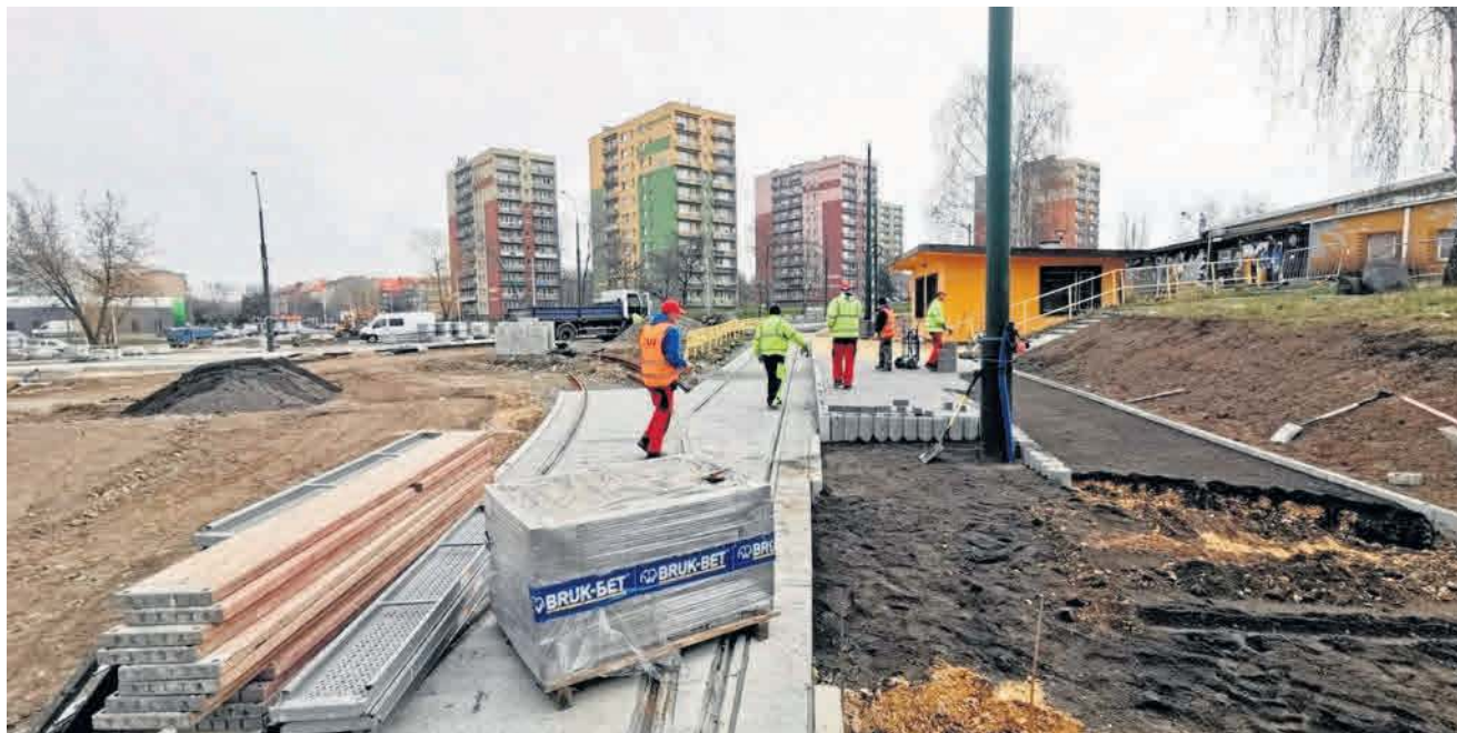
Nowe torowisko pod niskopodłogowe tramwaje na pętli tramwajowej w Czeladzi też jest w części już gotowe
