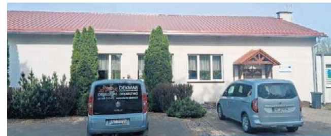
Dzięki przeprowadzonym pracom budynek świetlicy został lepiej zabezpieczony przed działaniem warunków atmosferycznych
