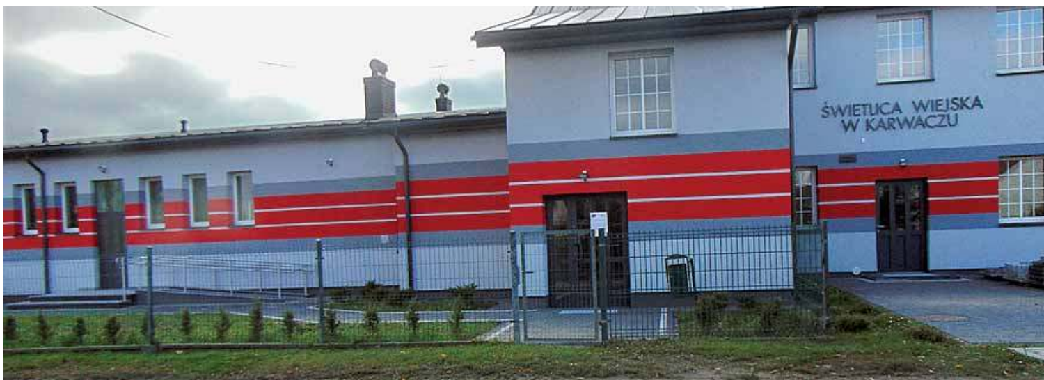
Przebudowa świetlicy gminnej w Karwaczu
