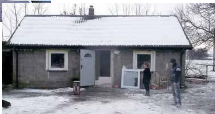
Ten dom po odbudowie
