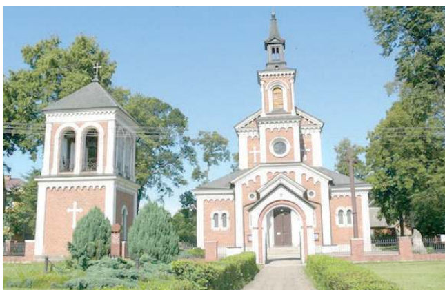
W kościele w Tuchowiczu będzie renowacja wnętrza, organów oraz zabytkowych pomników, elewacji, kostki
