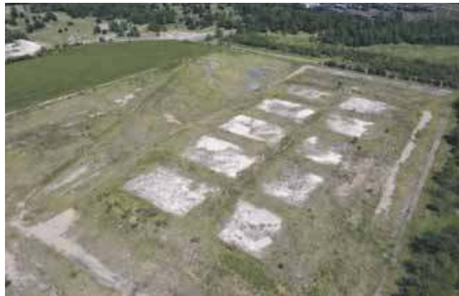
Na składowisku niebezpiecznych odpadów są nadal otwarte kwatery. Czekają na wypełnienie od 10 lat
