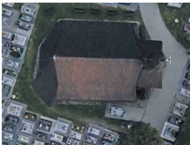
Jednonawowy kościół został wzniesiony na rzucie zamkniętego od wschodu trójbocznie prostokąta. Kruchtę dobudowano w 1702 r.
