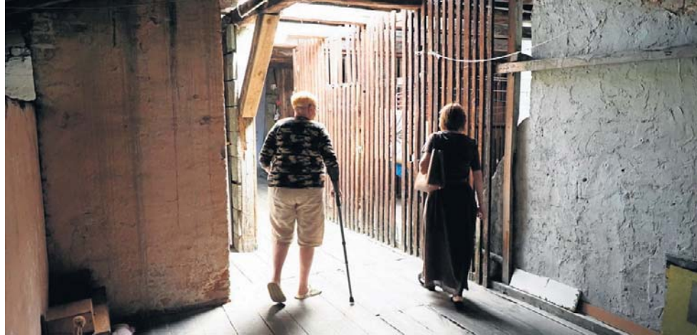
Lokatorki ze strychu są szczęśliwe, że po 5 miesiącach domofon jest naprawiany i ustalono przyczynę zapachu spalonych przewodów
