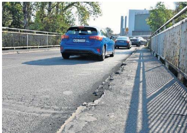
Kontynuowana będzie m.in. przebudowa wiaduktu w ciągu ulicy Nowej w Chorzowie
