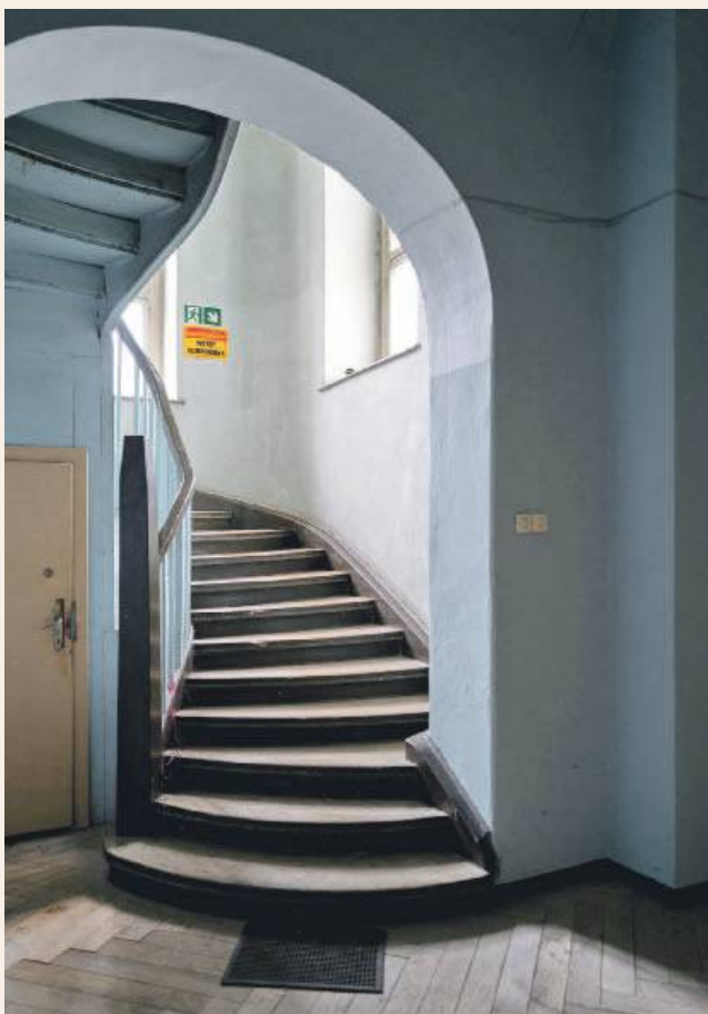
Klatka schodowa w pałacu - stan obecny
