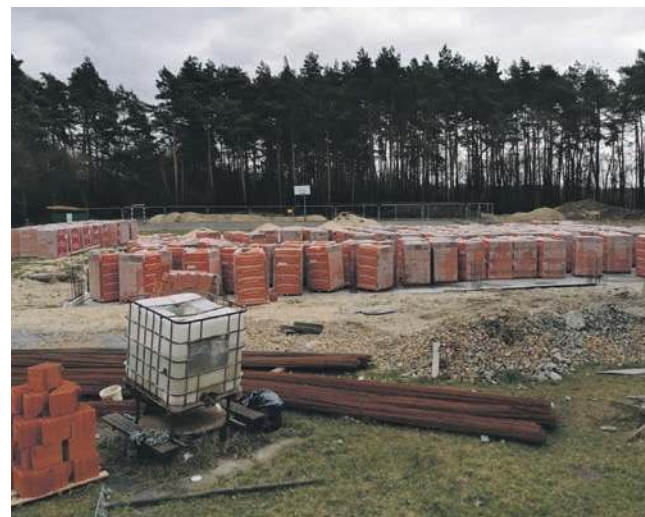
W tym miejscu powstaje sala gimnastyczna
