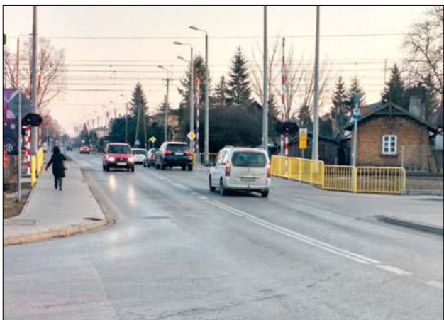
Przejazd przez tory na ul. Łomaskiej to skomunikowanie z cen-trum miasta osiedla, na którym mieszka około 5 tys. białczan. Kilka lat temu został zmodernizowany
