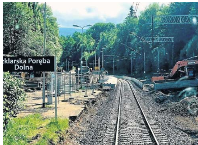
Prace na linii Jelenia Góra - Szklarska Poręba pozwolą na wzrost prędkości pociągów nawet do 100 km/h
