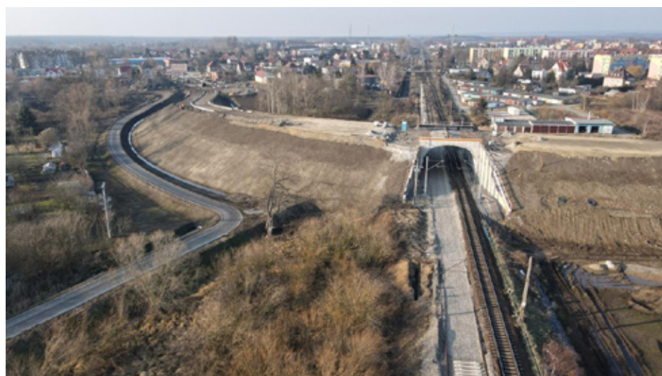
Luty 2025. Obejście w trakcie budowy.
