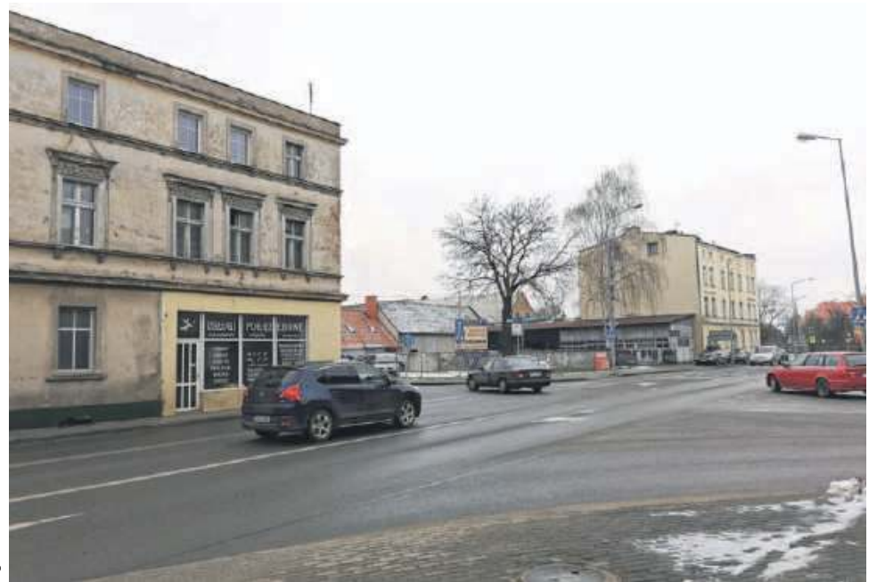
Budynek widoczny po lewej będzie wyburzony
