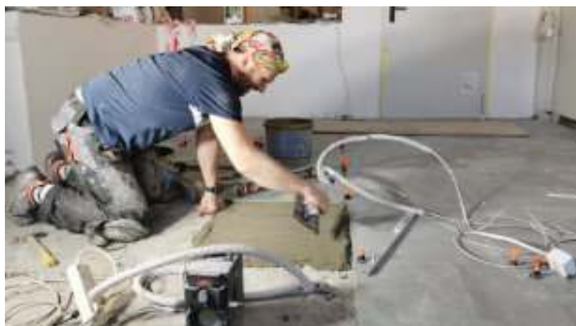
► Dzięki prowadzonym remontom budynki zyskują na estetyce i spadają koszty ich utrzymania Fot. Igor Cieśllicki (2)
