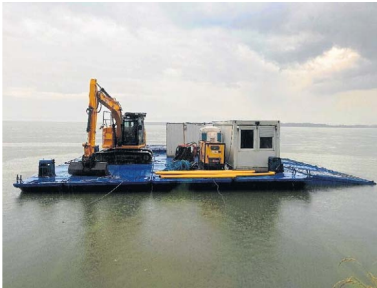
Będzie remont generalny zapory zbiornika wodnego Goczałkowice
