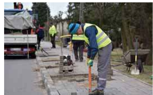
Drzewa zostały usunięte, teraz czas na uzupełnienie chodnika
