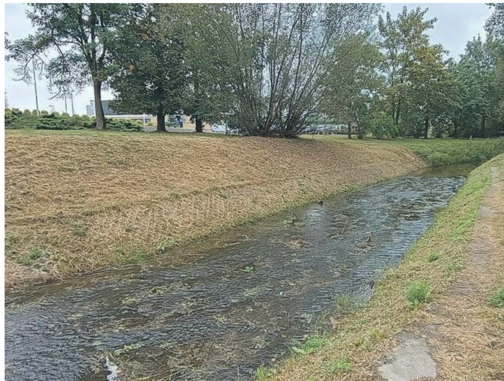
Rekordowo niski poziom wody widać m.in. w Luszówce na wysokości bloków przy ulicy Trzebińskiej w Chrzanowie
