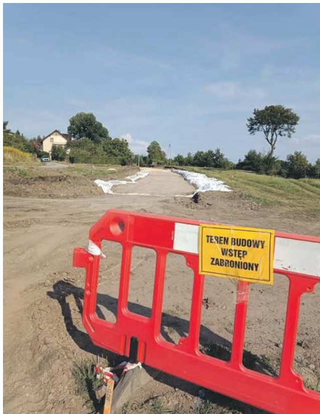
Trwają roboty budowlane
