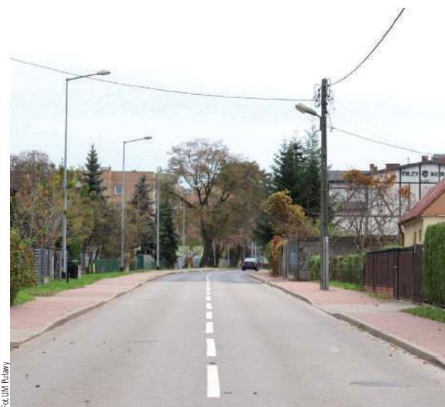
Remont ul. 6 Sierpnia trwał prawie dwa miesiące. Prace obejmowały odcinek o długości 410 metrów od ul. Wiślanej do wyniesionego przejścia dla pieszych
