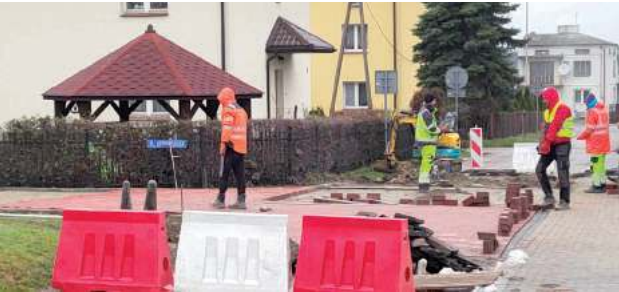
Wyniesione skrzyżowanie z jednej strony spowolni ruch, a z drugiej ułatwi wejście na chodnik np. osobom niepełnosprawnym lub z wózkiem. Prace nad jego budową zakończyły się przed świętami
