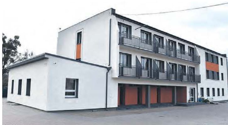
Budynek zaplecza administracyjno-sportowego OSiR już w nowej szacie. Zostały dofinansowane w 95% w ramach środków z Rządowego Funduszu Polski Ład: oraz związanej z nią infrastruktury drogowej na terenie gminy Tuchola.
