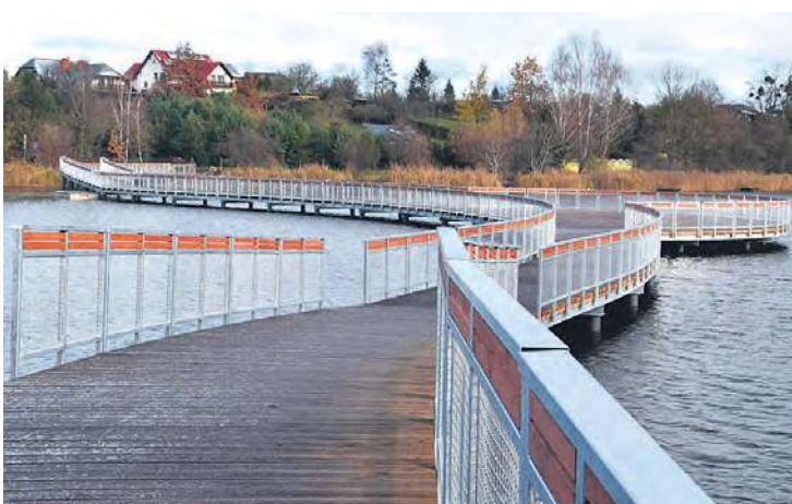
Tak prezentuje się promenada przez jezioro Głęboć. Zostanie tu zamontowane jeszcze oświetlenie w postaci energooszczędnych lamp LED.
