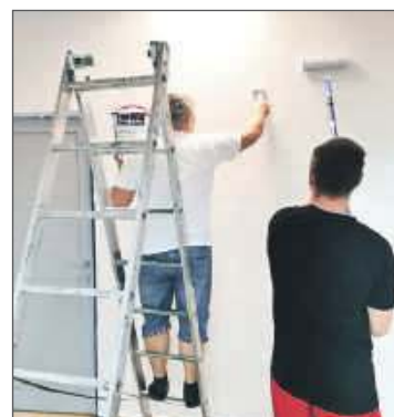
Malowanie w kompleksie Nemo.
