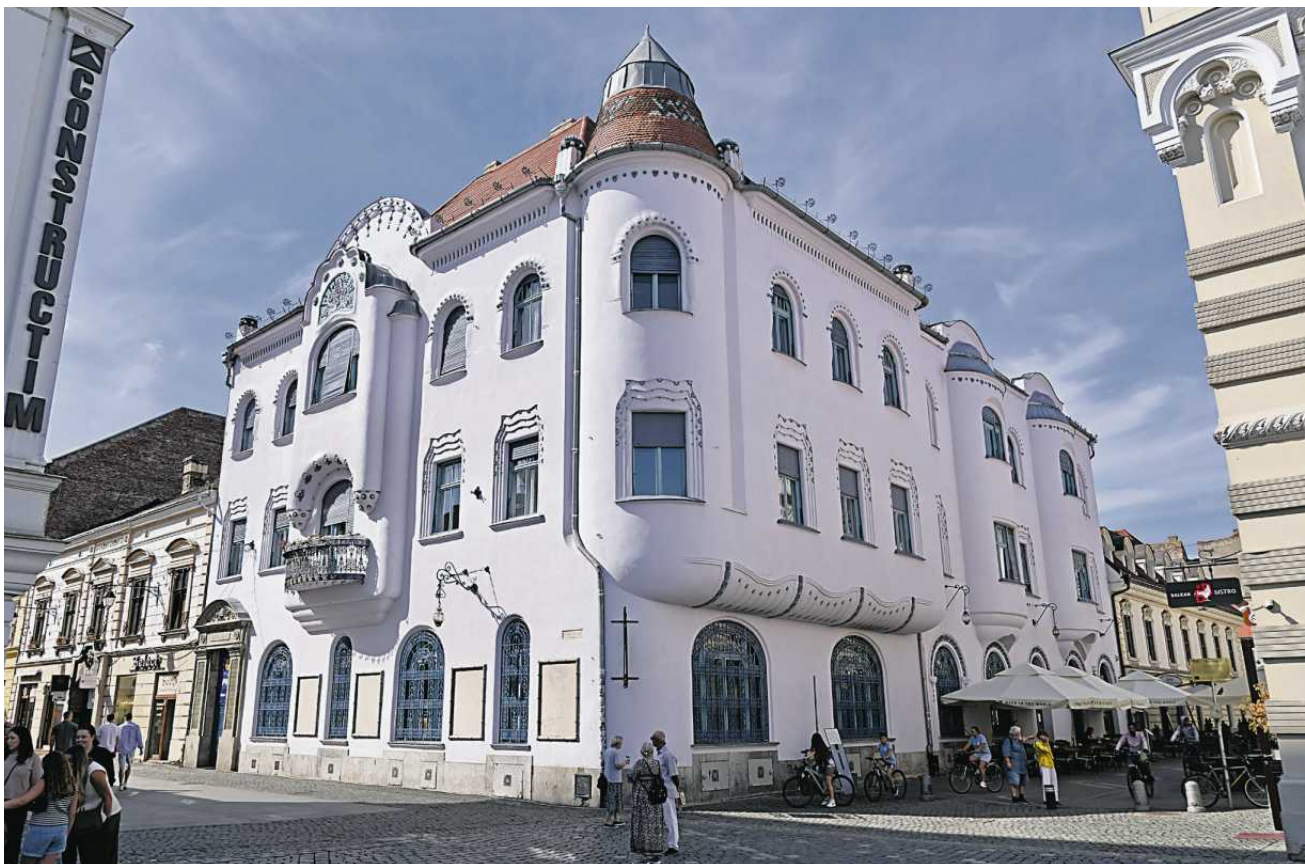
• Pałac Steinera przy Placu Unii. Perła secesji węgierskiej w Timisoarze. W 1909 r. jego budowę sfinansował Maks Steiner. Mieścił się tu Bank Dyskontowy Południowych Węgier
