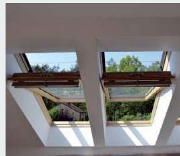
❸ Okna obrotowe o wysokości 1,60 m pogrupowano po 2–4 sztuki.
