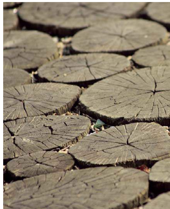
📌 Bruk drewniany nadaje się wyłącznie na trakty przeznaczone dla pieszych. DREAMTIME
