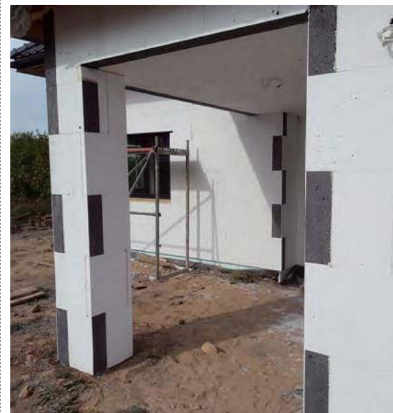
📍 Szary styropian zespolony z cienką białą warstwą zewnętrzną jest niewrażliwy na działanie słońca. Biała warstwa odbija je i płyta się nie nagrzewa. SWISSPOR
