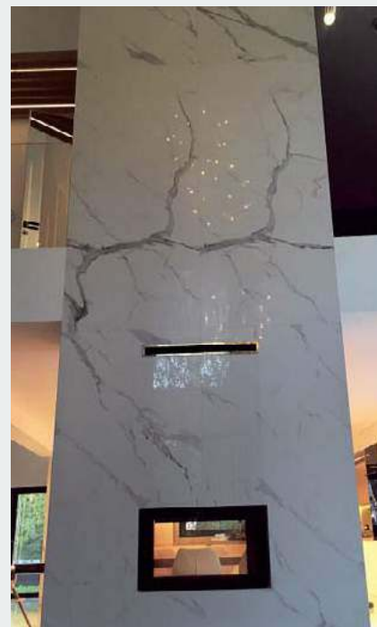
❷ Ścianę z kominkiem wykończono płytami gresu 120 × 240 cm.
