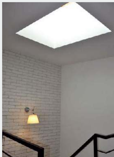
W płaskim dachu zamontowano okno, głębokie gify imitują świetlik.
