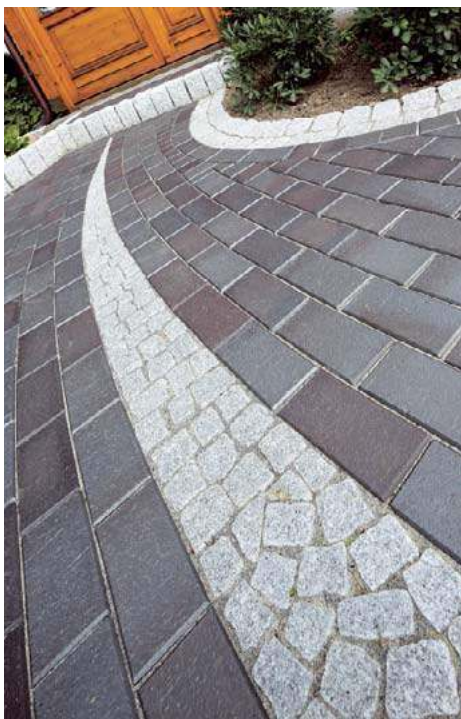
📌 Kamienna kostka i bruk klinkierowy – dwa bardzo trwałe materiały połączone na jednej ścieżce. LHL KLINKIER
