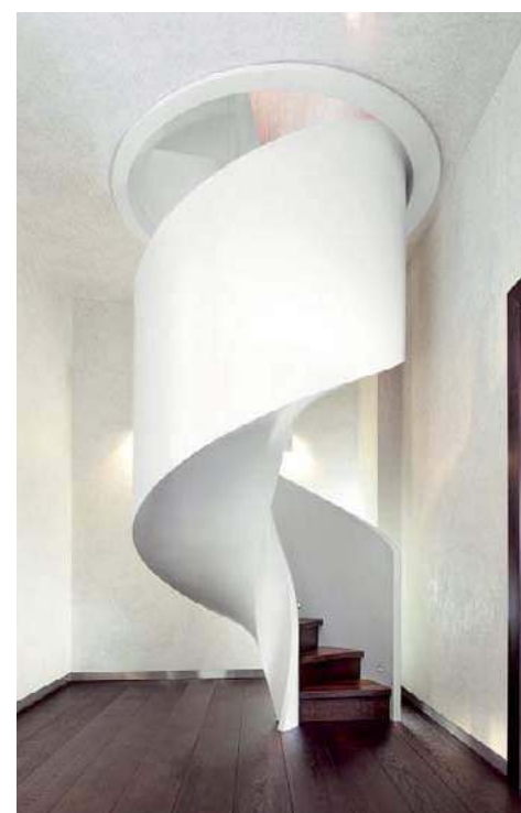
❷ Schody spiralne z płycinową balustradą i zabudową spodu. Wykonane z wędzonego dębu i malowanego drewna. TRĄBCZYŃSKI
