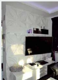
1 Panele 3D z gipsu na całej bocznej ścianie salonu.
