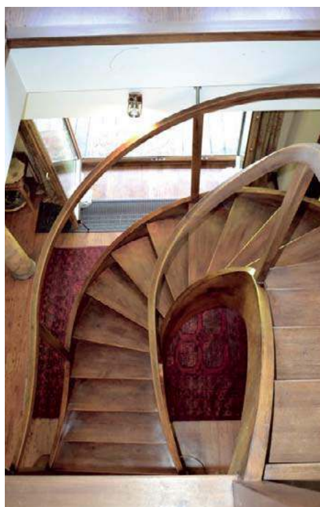
❶ Spiralne schody wykonane z drewna sosnowego, zaimpregnowanego woskiem. Artystycznie wygięte półeczki (wagi) są ich największą ozdobą. L. JAMPOLSKA
