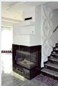
3 Panele 3D z wzorem kwietnym przytwierdzono klejem gipsowym.
