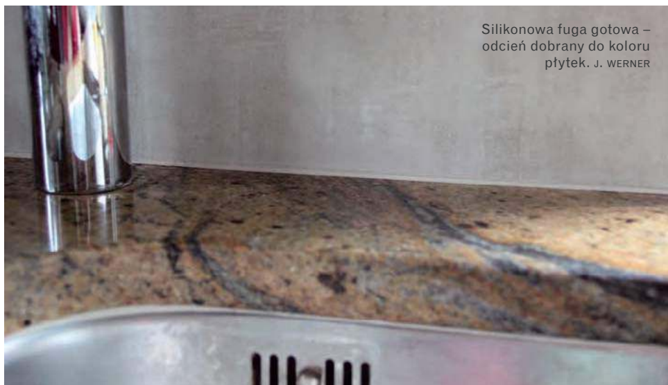
🔧 Nadmiar silikonu usuwa się specjalną szpachelką/kształtką (a sopro) albo – jak w tym przypadku – palcem mocznym w wodzie z dodatkiem mydła lub płynu do mycia naczyń (b A. WERNER).
