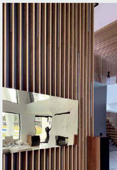
➔ Pionowe elementy 3D przyczepiono do ściany za pomocą kotew stalowych.
