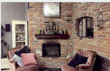
Ścianę przy kominku postawiono z cegły rozbiórkowej.
