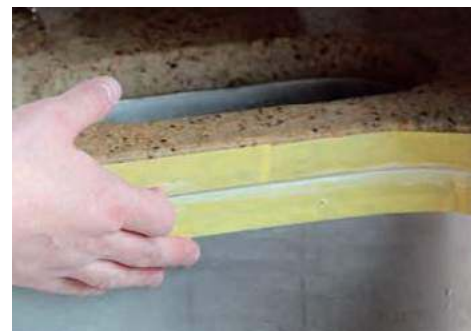
🔧 Nadmiar silikonu usuwa się specjalną szpachelką/kształtką (a sopro) albo – jak w tym przypadku – palcem mocznym w wodzie z dodatkiem mydła lub płynu do mycia naczyń (b A. WERNER).
