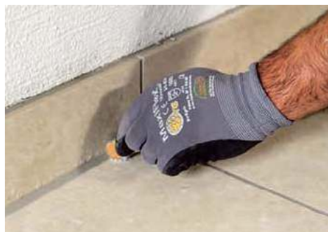
🔧 Nadmiar silikonu usuwa się specjalną szpachelką/kształtką (a sopro) albo – jak w tym przypadku – palcem mocznym w wodzie z dodatkiem mydła lub płynu do mycia naczyń (b A. WERNER).
