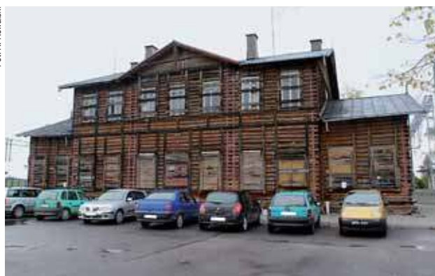
Nieczynny dworzec w Gąsolinie pod względem architektonicznym nadal wygląda interesująco
