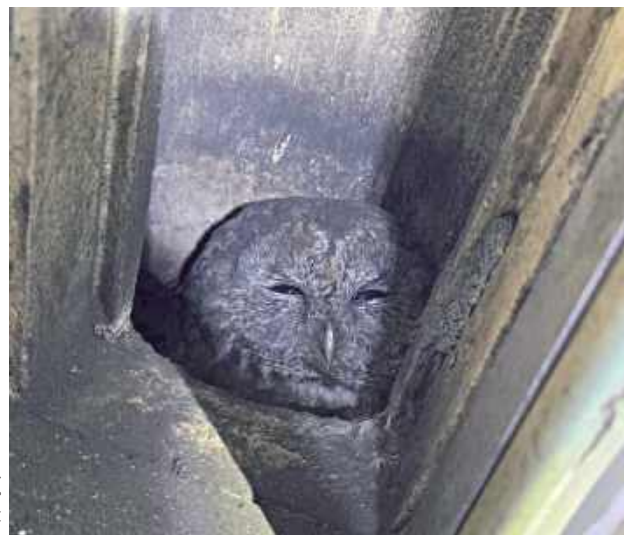
Sowa była uwięziona w przewodzie kominowym
