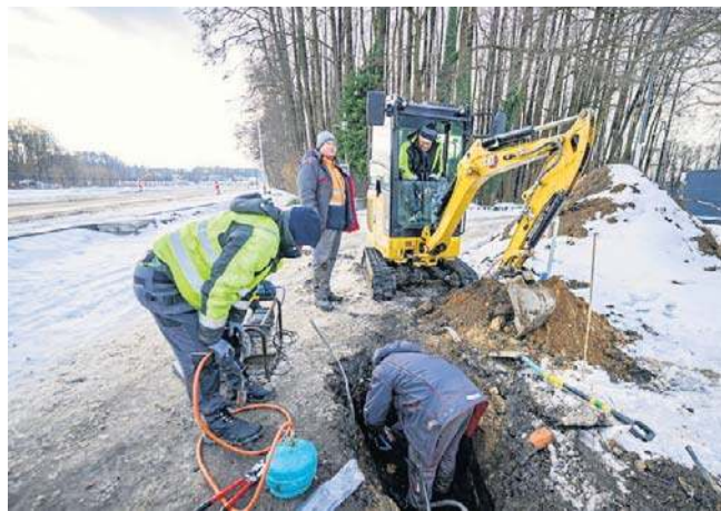
Ostatni odcinek ul. Szczecińskiej będzie gotowy na wiosnę
