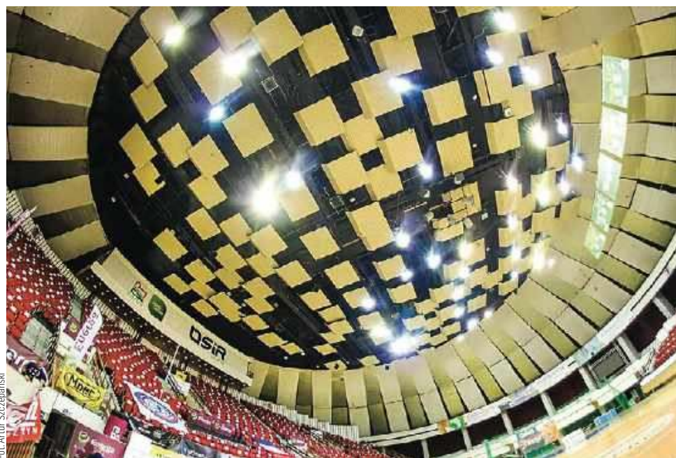
Mimo upływu lat olsztyńska hala nadal nieźle wygląda na... dobrze skadrowanych zdjęciach
