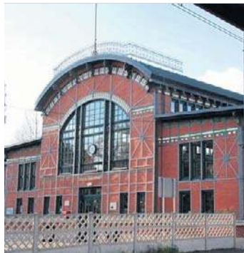
Stacja Biblioteka w Rudzie Śląskiej
