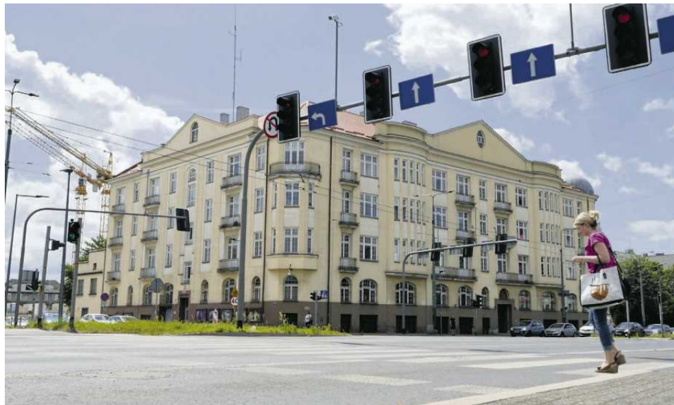
• Dawna kamienica Reicherów w Sosnowcu FOT. UM W SOSNOWCU
