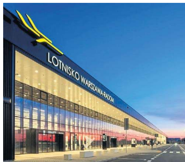
FOT. LOTNISKO WARSZAWA - RADOM
