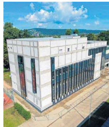
Budowa rozpoczęła się w lipcu 2024 roku
