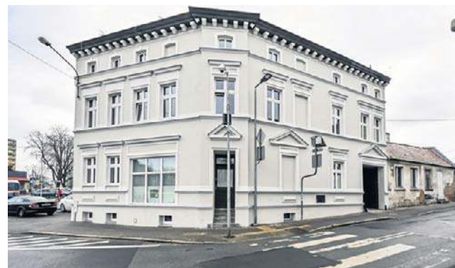
Przy charakterystycznym skrzyżowaniu na Szwederowie odnowiono między innymi tę kamienicę
