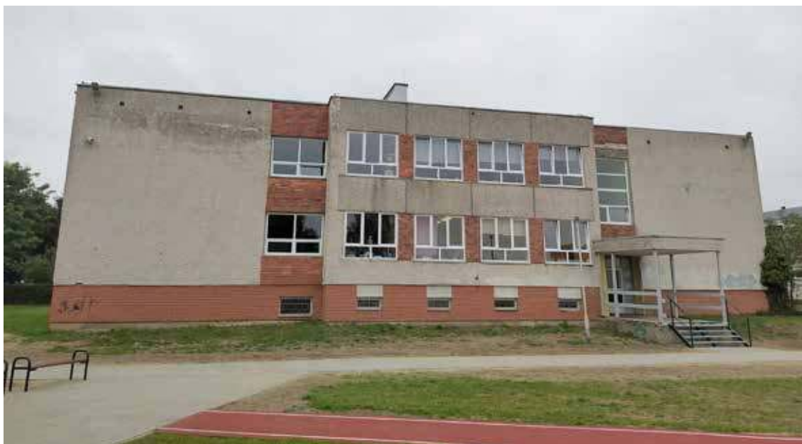
W planie gminy jest termomodernizacja budynku, w którym mieści się II LO oraz SP nr 3
