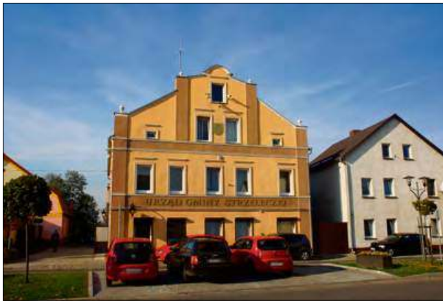
W planie remontów na ten rok jest również przebudowa budynku A urzędu gminy.
