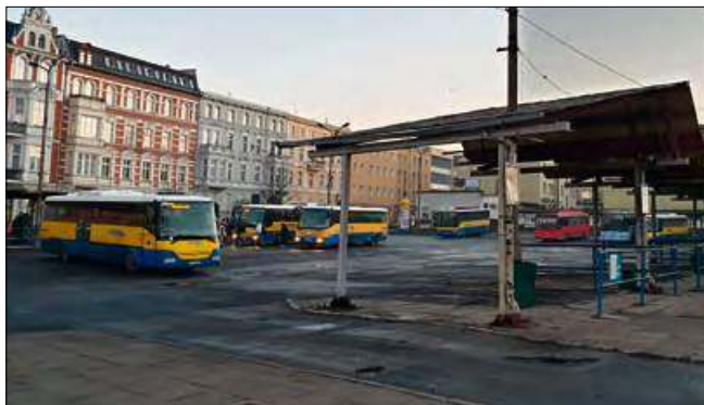
Na płycie dworca autobusowego powstanie centrum przesiadkowe.
