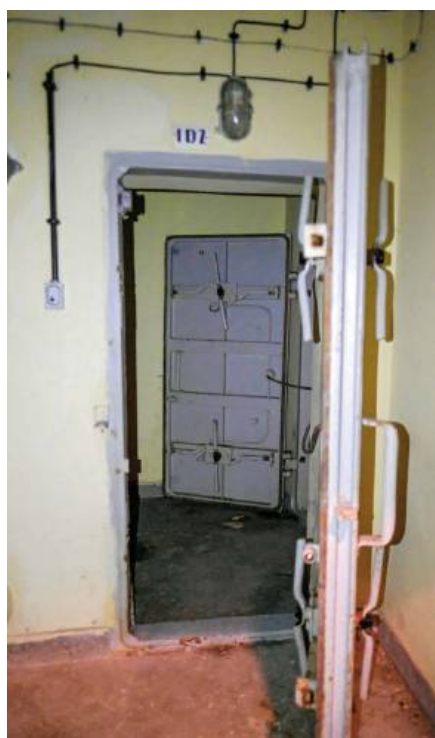
Schron Marysieńka w Rzeszowie. U góry: rozważane miejsce schronienia pod warszawskim metrem.
