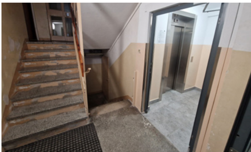
Fot. 4. Stan po przebudowie na poziomie 0, ul. Magellana 14, Warszawa
