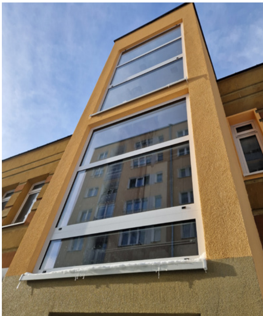
Fot. 2. Dobudowany szyb oraz zamontowany dźwig, ul. Grójecka 109, Warszawa
