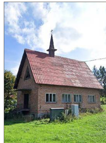
Coraz bliżej przebudowy kaplicy.
