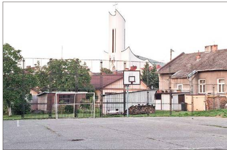
Boisko wymaga remontu.
