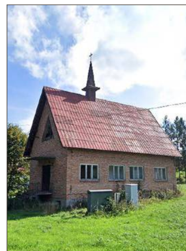
Coraz bliżej przebudowy kaplicy.
