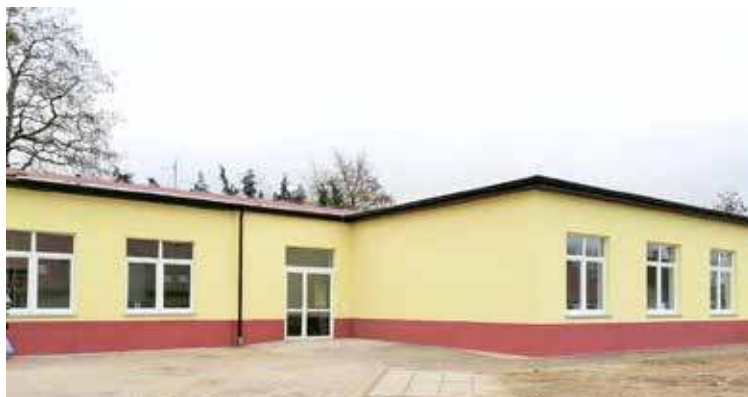
Dobudowana część SP w Racimierzu - widok od głównego wejścia Fot. Gmina Stepnica
