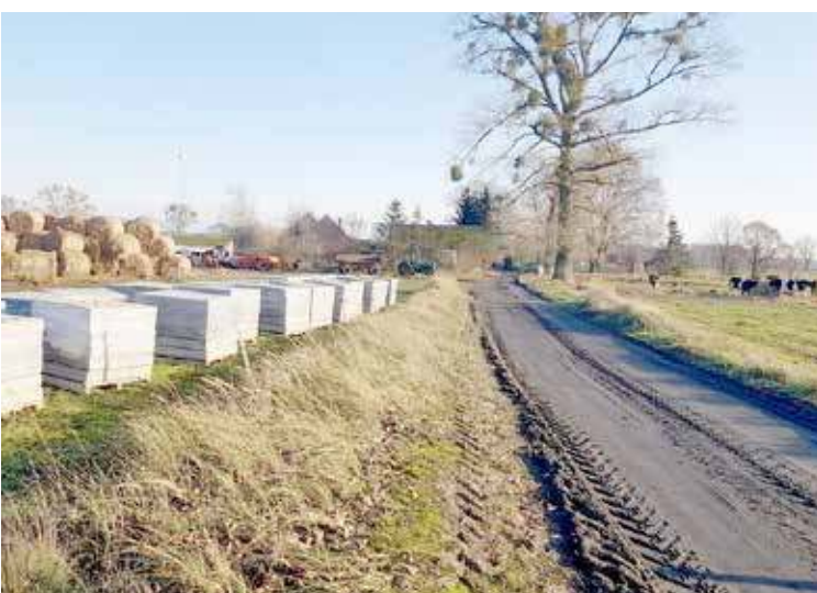
Kępy Lubczyńskie, tu też postanowiono drogę gruntową utwardzić za pomocą płyt jumbo, Fot. radny A. Różański, fb
