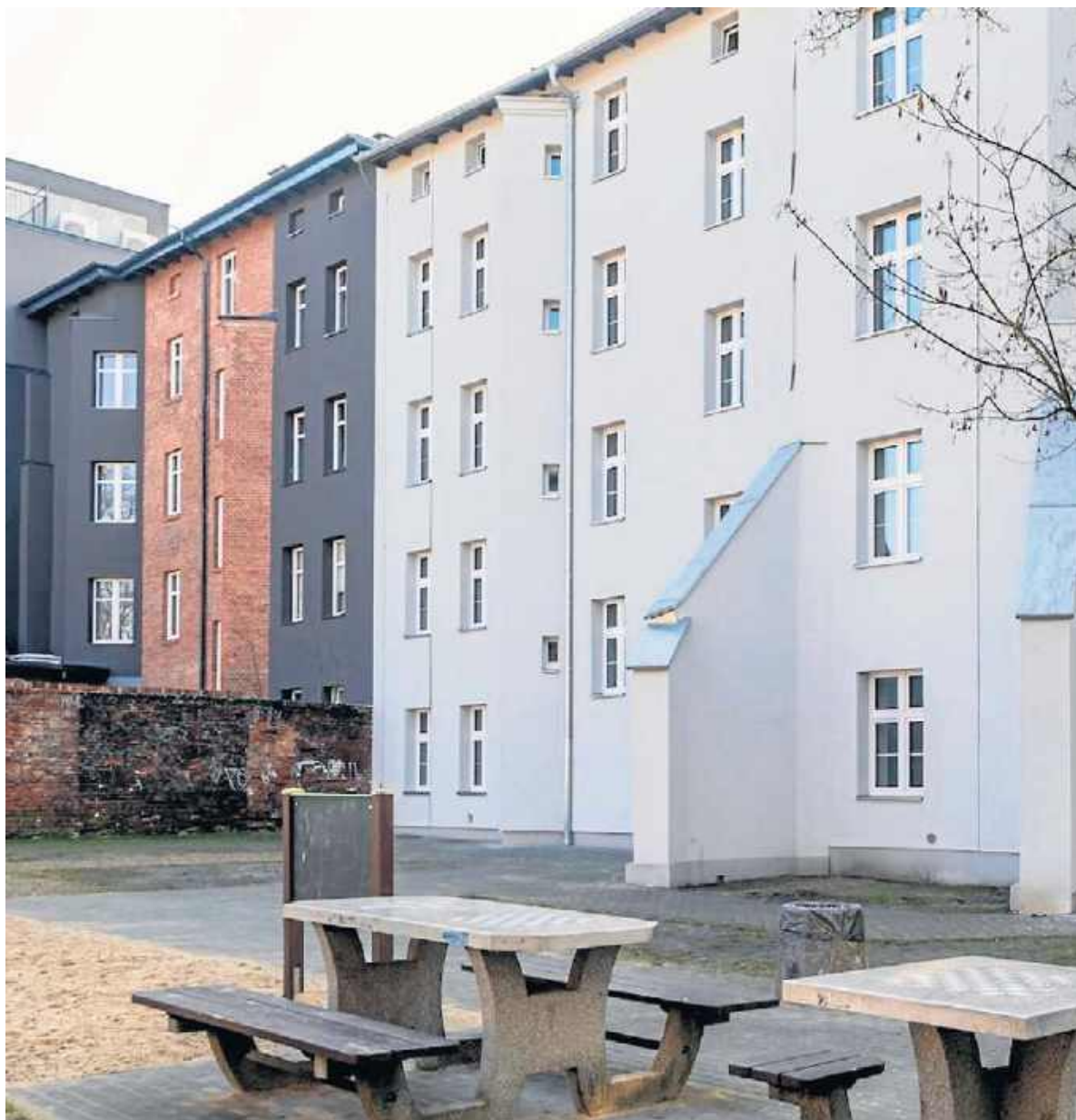
FOT. UM BYTOM
