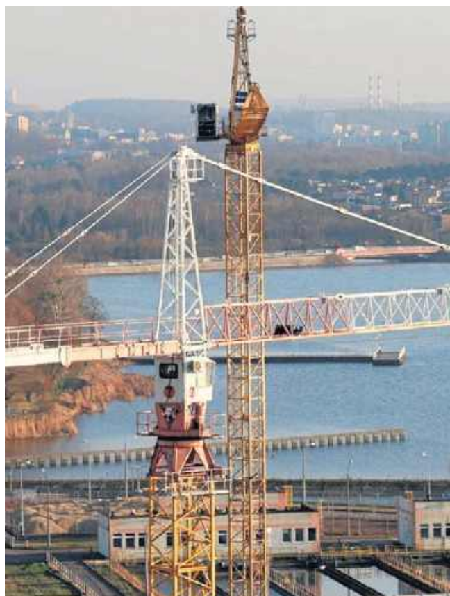
Budowę bloku gazowo - parowego rozpoczęto w 2024 r.
