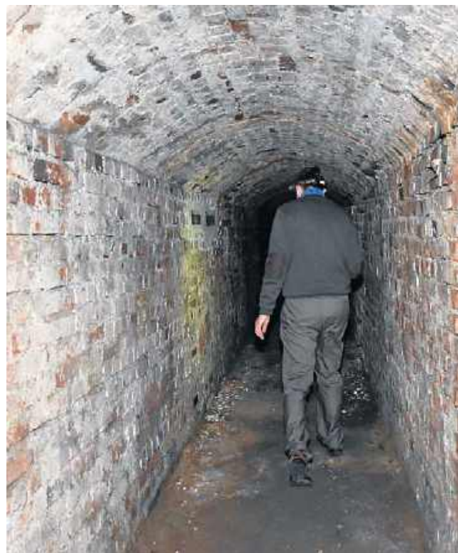
Szczelina przeciwlotnicza ma 60 metrów długości
