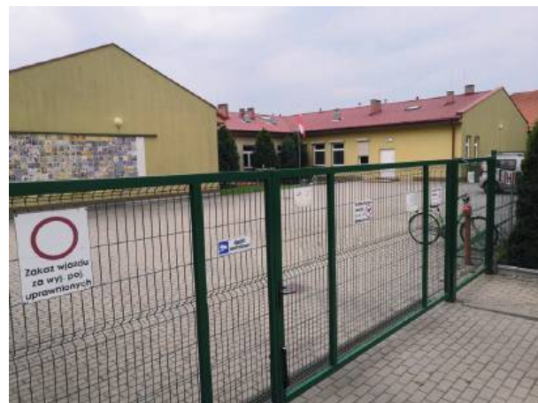
W Przedszkolu Miejskim w Wiązowie trwają prace związane z wymianą ogrzewania. To jednak nie koniec inwestycji w tym miejscu
