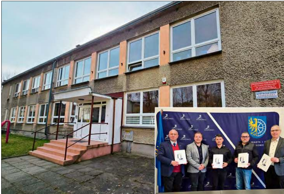
Otmękie przedszkola przejdą gruntowny remont termoizolacyjny.
