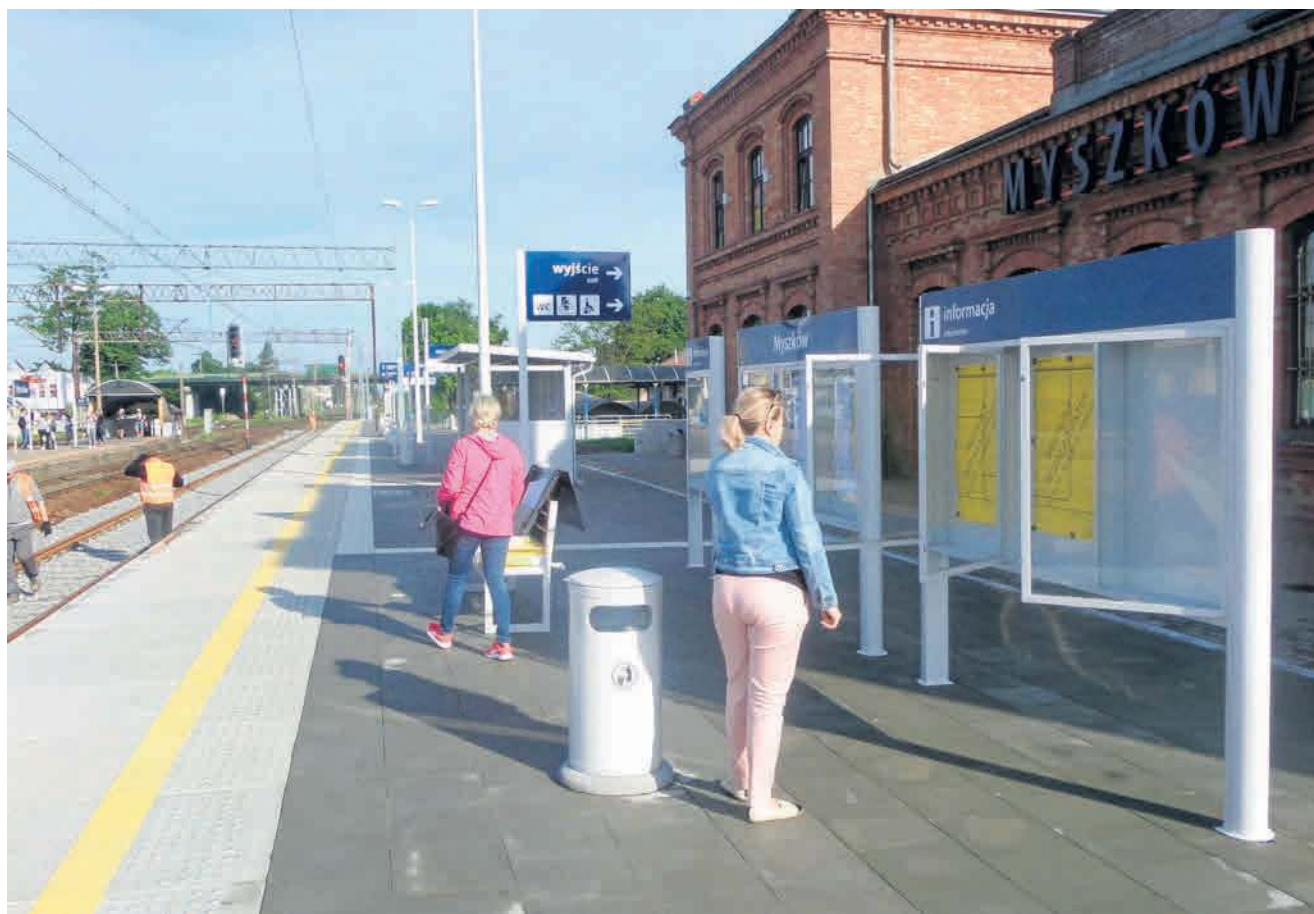
W Myszkowie jest już gotowy pierwszy peron, przy budynku dworca. Jest nowa nawierzchnia, nowe gabloty oraz wiaty
