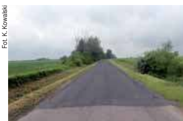
Nowo położona nakładka asfaltowa zakryła największe dziury
