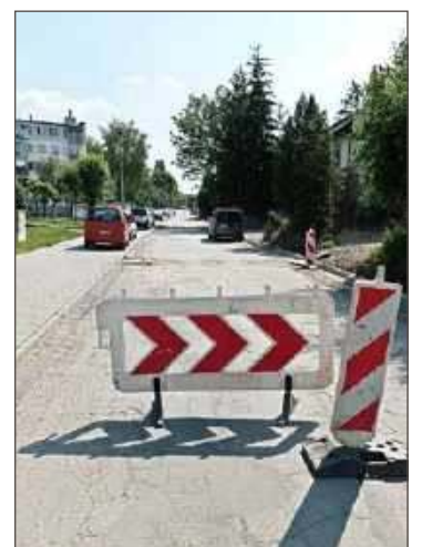
Prace na Tuwima już trwają.
