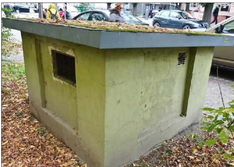
Schron przy ul. Sobieskiego. Nieczynny.
