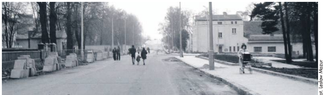
Rok 1973 - remont ulicy 1 Maja. W głębi kończy się budowa wiaduktu nad torami kolejowymi, a po prawej trwa remont skweru, na którym będzie stał pomnik gen. K. Świerczewskiego
